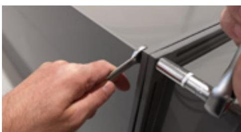
6. Die Sechskantschraube DIN 6921 M8 x 35 und Sechskantmutter DIN 6923 M8 mit 14 Nm fest anziehen.
