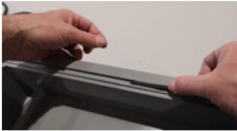
1. Flanschrahmen reinigen und gegebenenfalls trocknen.
