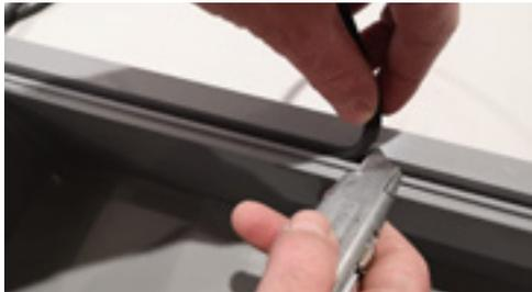
2. Auf die Stirnflächen die chemisch beständige EPDM Dichtungsschnur in die dafür vorgefertigte Nut zugfrei einlegen.
