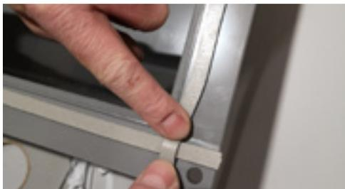
3. Das Dichtungsband muss an den Ecken über Kreuz geklebt werden
