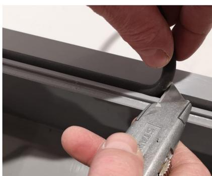
2. Auf die Stirnflächen die chemisch beständige EPDM Dichtungsschnur in die dafür vorgefertigte Nut zugfrei einlegen.
