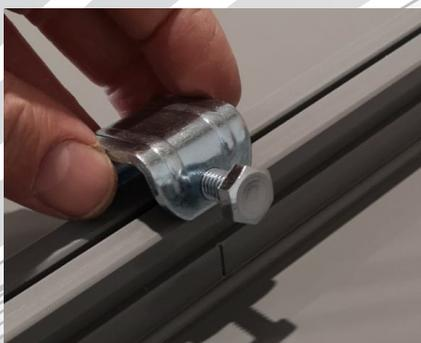
8. Kanalklammern mit 23 mm Spannbereich in Abständen von 150-200 mm in die Nut einsetzen und mit 4 Nm fest anziehen.
